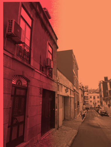
Ampersand (vue extérieure).
