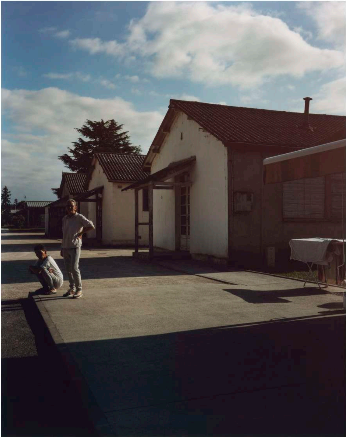
Deux des sœurs de la famille Caze, Claudine et Monique, devant les quatre derniers bâtiments d'origine du camp.
