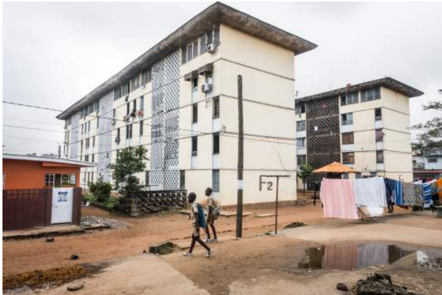
Bâtiment F2 des 220 Logements. Abidjan. Novembre 2020.
