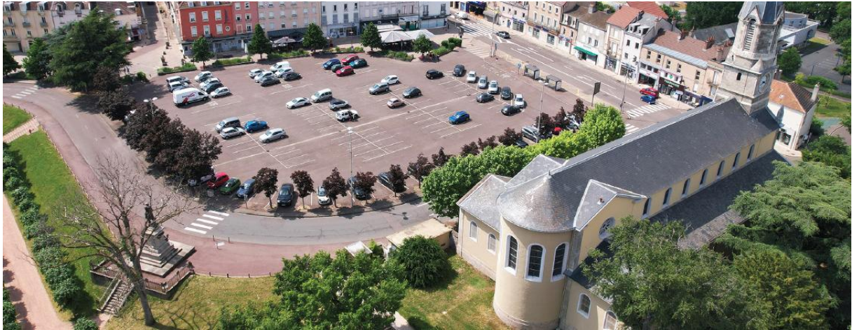
Vue aérienne de la place Schneider avant réaménagement
