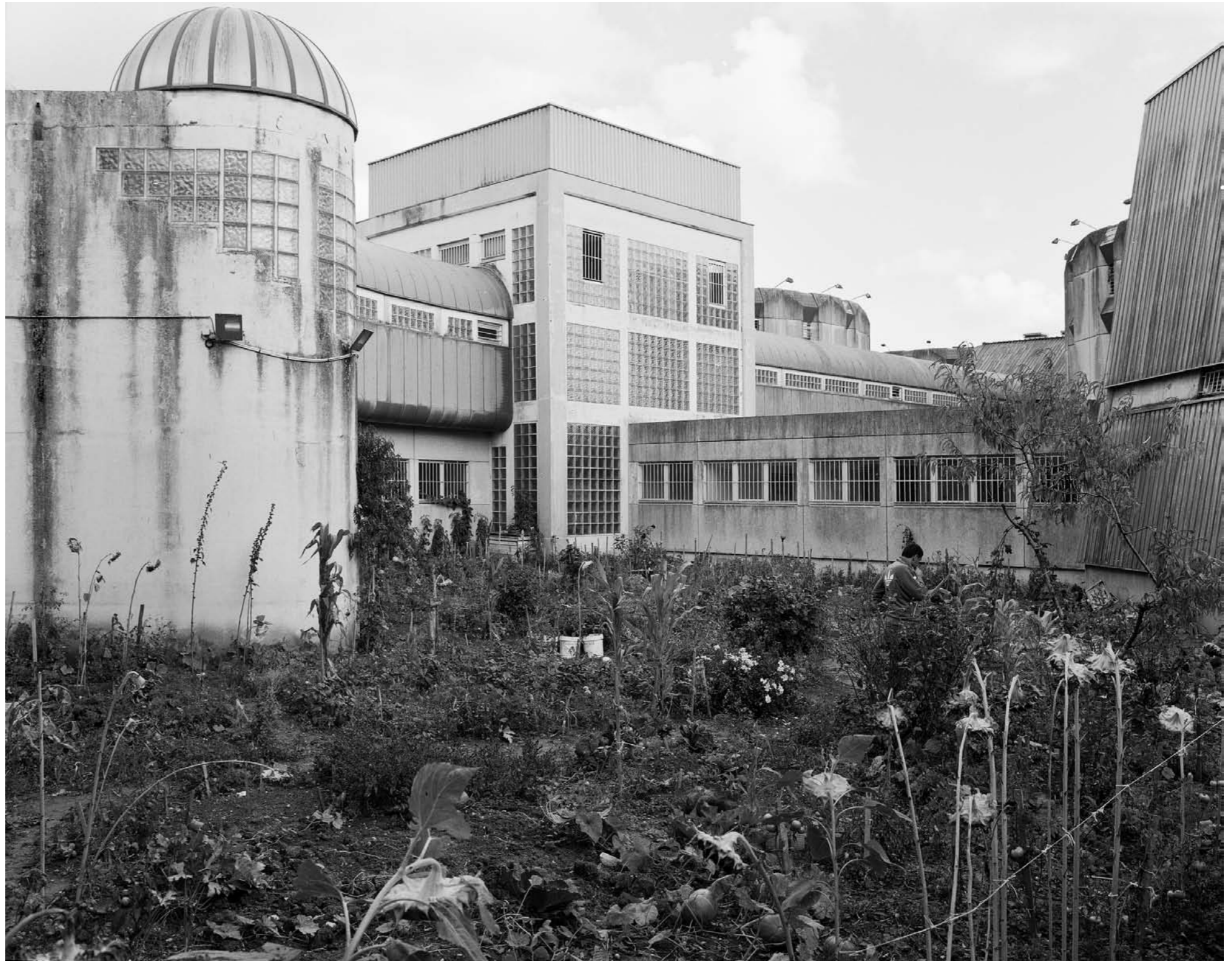
Centre de détention de Val-de-Reuil, vue de l'architecture depuis le jardin- potager cultivé par quelques prisonniers, septembre 2017
